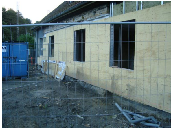
Facade af Risvangsalle 1/3. Sommeren 2015.
