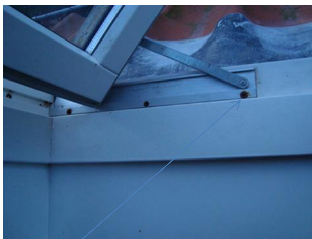
Eksempel på rustne skruer.
