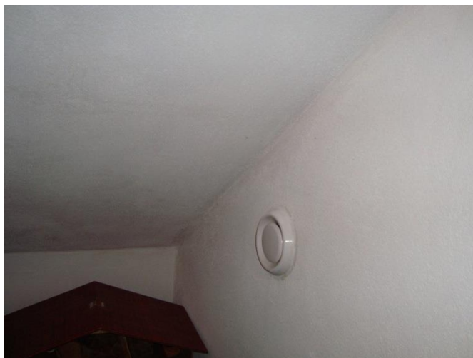
Foto fra Prøverummet Grenåvej 2. 10.3.18
