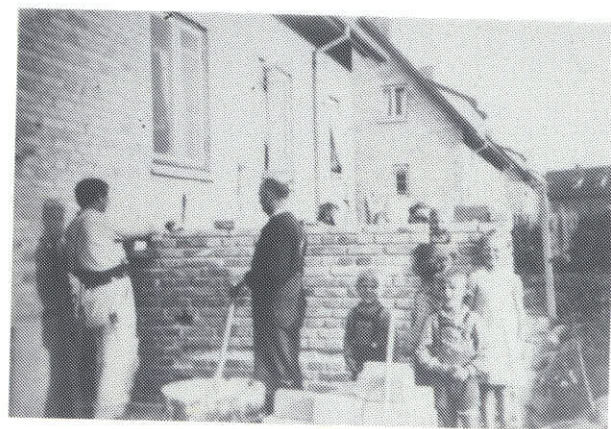
Havemur opføres mellem Hans Egedes Vej 65 og 67
